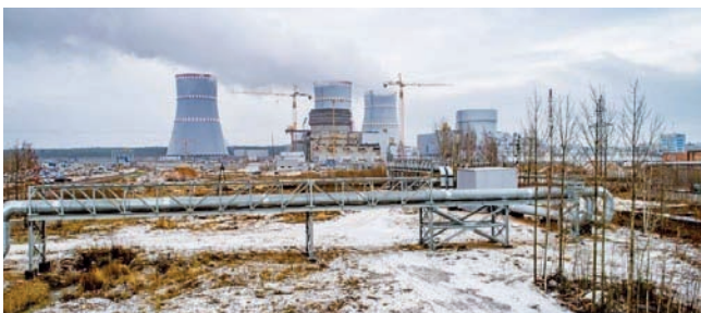
Obr. 16 Horúcovody v sosnovoborskom mestskom okruhu
