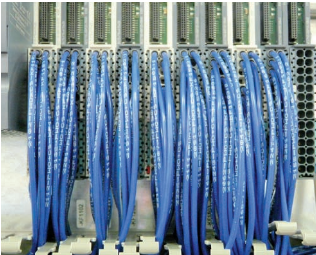
Vo firme Alexander Bürkle sú káble automaticky označované priamo zo systému EPLAN.
