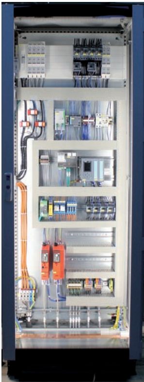
Príklad z výroby rozvádzačov...
